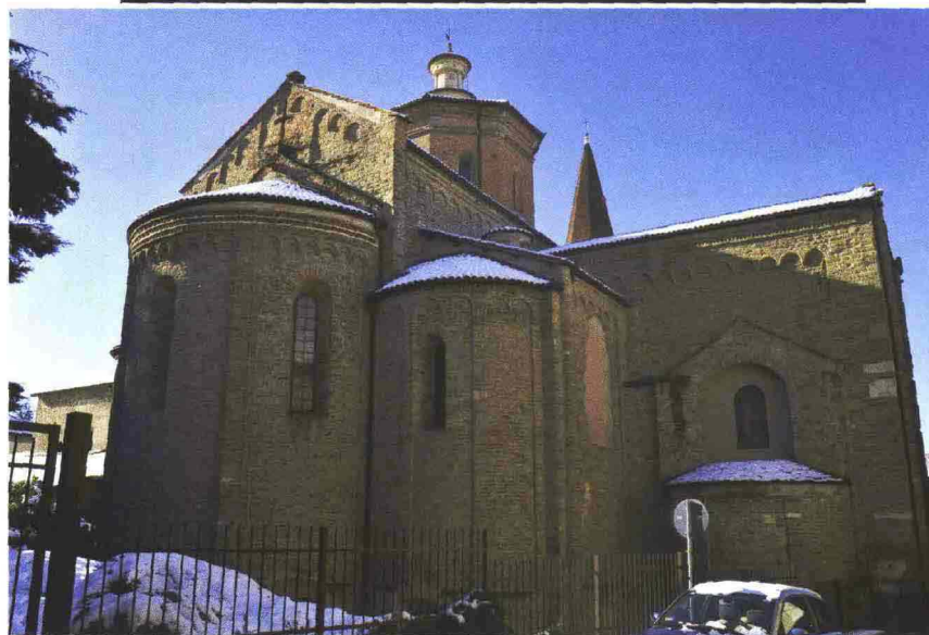
Dall'alto: la facciata del Duomo; le absidi romaniche della cattedrale
